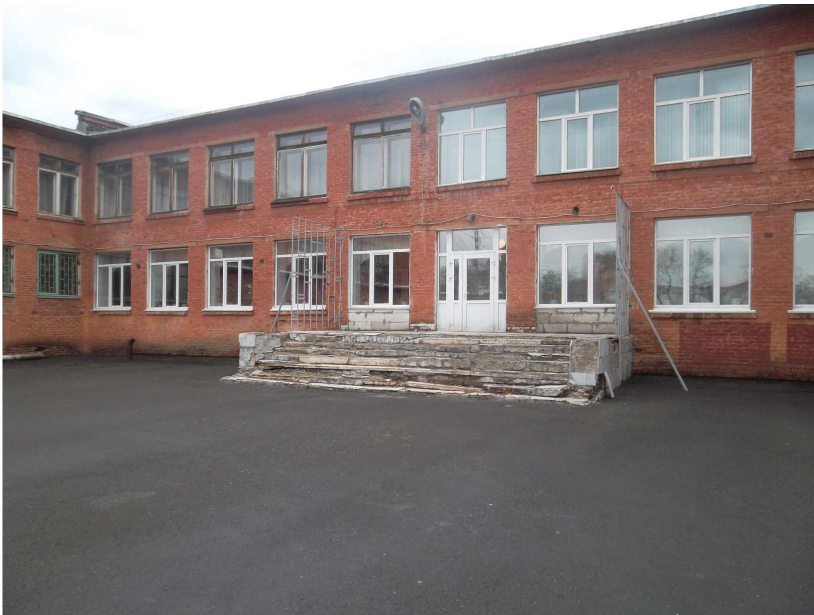
Рис. № 18 «Лестница наружная»
