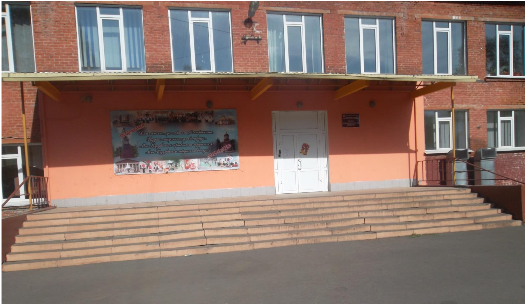
Рис. № 17 «Лестница наружная»
