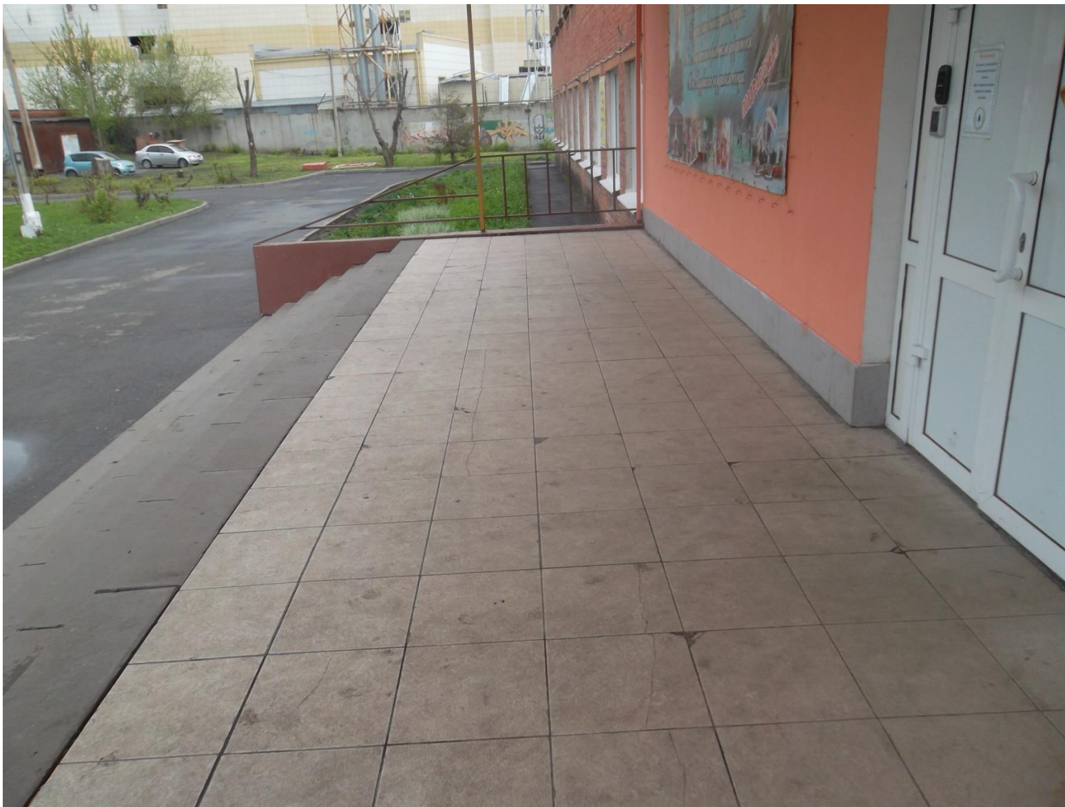
Рис. № 19 «Входная площадка (перед дверью)»
